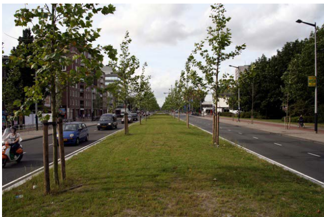
Bovengrondse verankering Wibautstraat (foto: Cécile Obertop)
