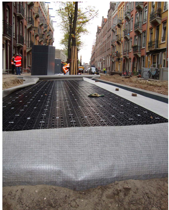
Constructie onder verharding tbv bomen in parkeervoorziening, Balistraat (foto: Jan Wilem Obbink)
