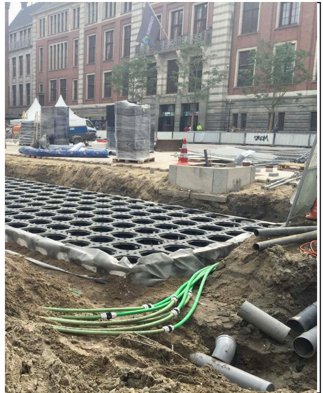
Ondergrondse constructie voor bomen bij hoge verkeersbelasting, Beursplein (foto: Herman Best)
