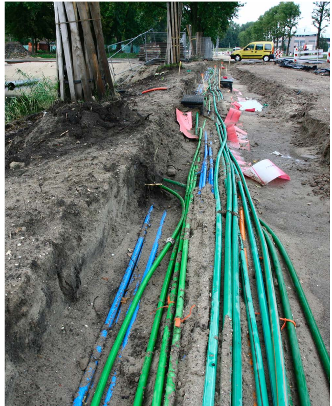
Afstand boom tot ondergrondse kabels en leidingen (foto: Hans Kaljee)
